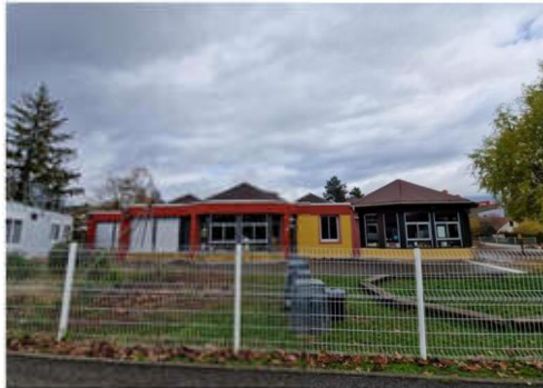
La commune va devoir emprunter pour pouvoir financer le chantier de la nouvelle école des Chavannes. Photo Le DL/A.G.
